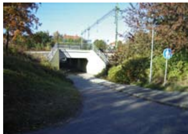
Gång- och cykeltunneln söder om stationen.
