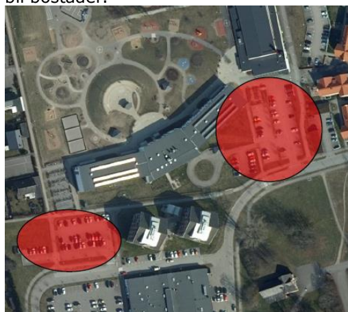
Figur 8. Parkeringar som används för angöring till skolan idag. Den västra parkering utgår enligt ny detaljplan för Lödde centrum.
