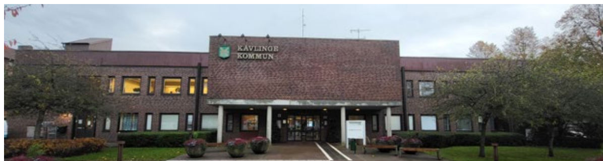
Fasad mot norr och huvudentré. Det utkragande partiet inrymmer fullmäktigesalen på andra våningen.
