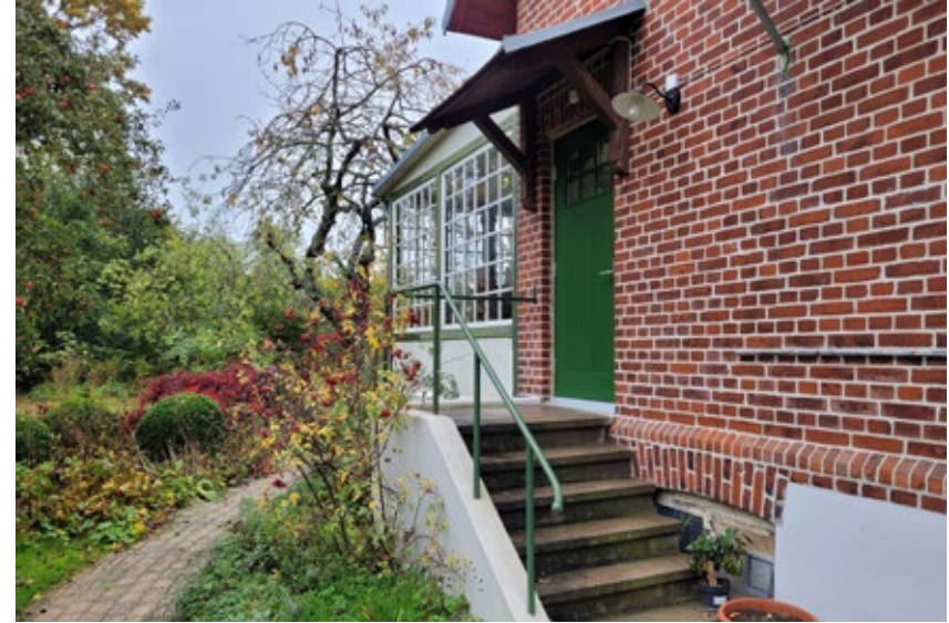
Sidoentré, södra fasaden.
