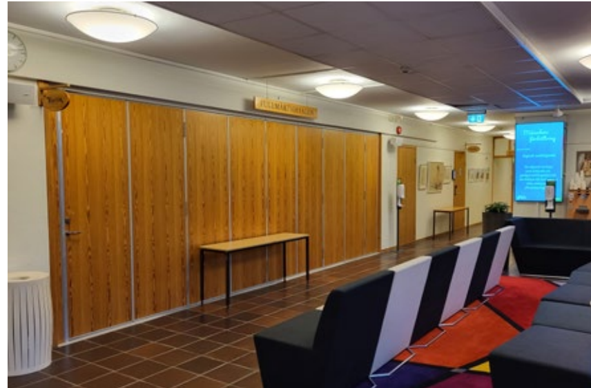
Foajé och korridor utanför fullmäktigesal. Dörrparti/vikvägg i omålat trä, golv av mörkbrunt Höganäsklinker.
