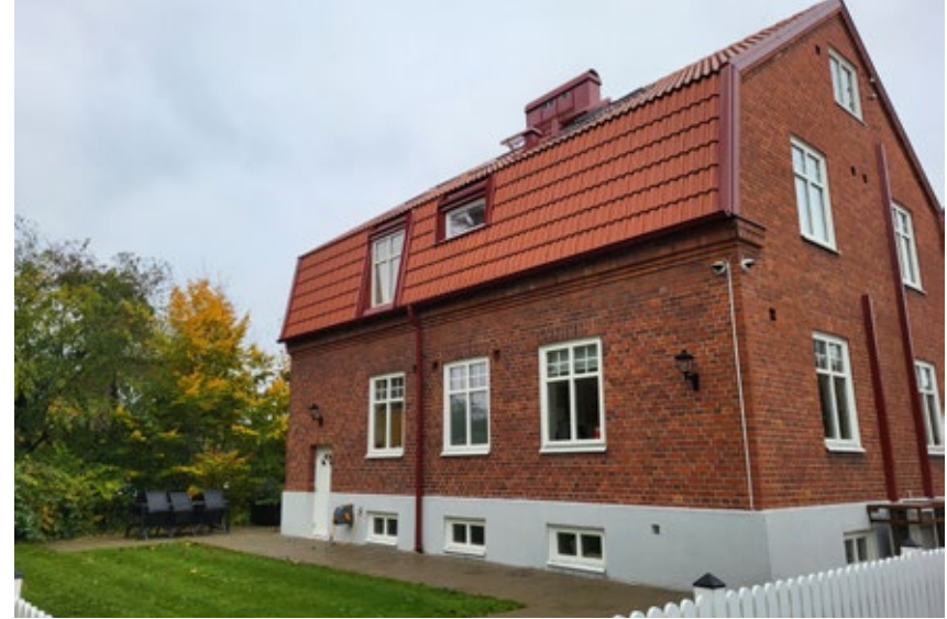
Fasad mot väst. Entré t.v.
