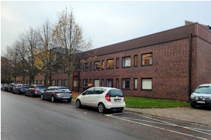
Vy mot söder längs Framtidsgatan, östra fasaden.
