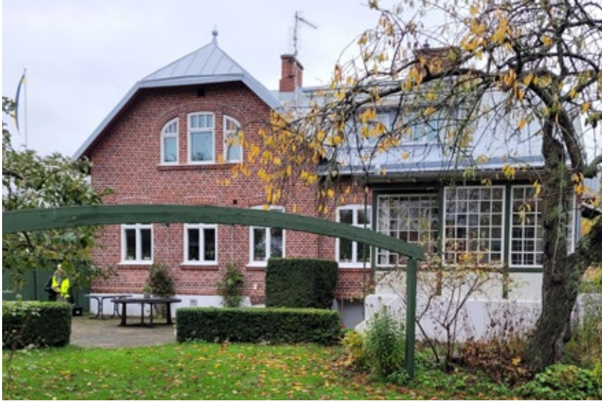
Västfasad och trädgård. Veranda t.h.
