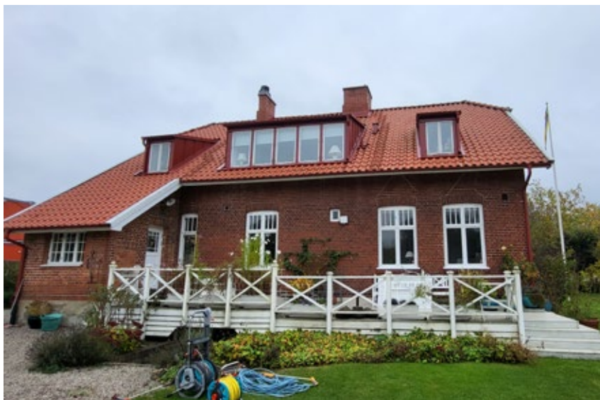
Västra fasaden, altan och trädgård. T.h. bevarade fönster med lodrätt småspröjsade överluffer. T.v. nyare fönster. Tre tillkomna takkupor. Murade skorstenar.
