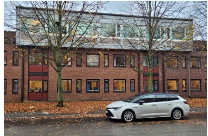
Del av östra fasaden. Ursprunglig del med något mörkare tegel t.h., tillbyggnad från 1973 centralt i bild, och påbyggd tredje våning (ev. från 2007) överst.
