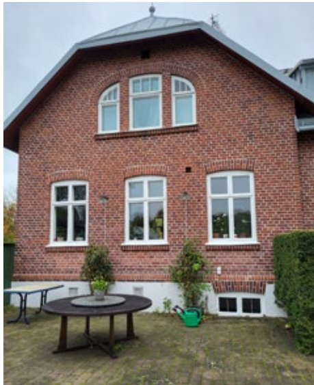
Västfasad, norra sidan.
