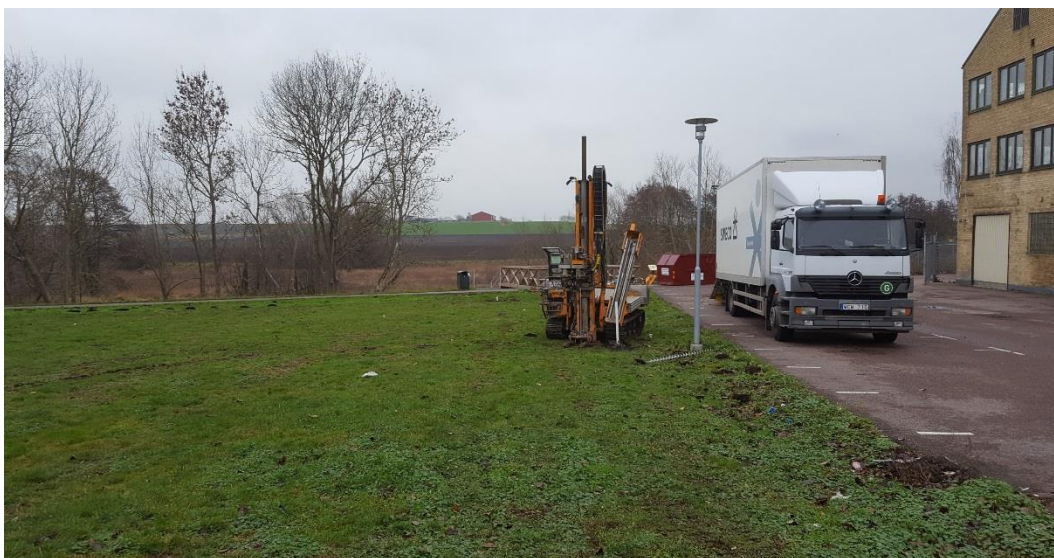
Figur 2. Vy mot söder tagen vid jordprovtagningen den 19 december 2018. På bilden ses del av gräsmattan och den asfalterade ytan. Till höger syns östra delen av byggnaderna på fastigheten Möller 2. Kävlingeån ligger bakom trädriddån i bakgrunden.
