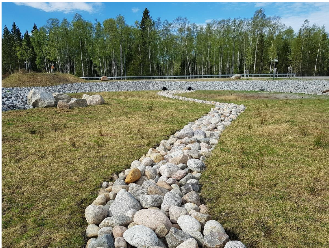
Figur 22. Torrdamm i Luleå (Sara Eklund AFRY, 2018).
