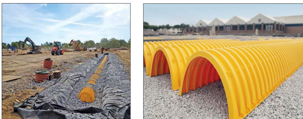
Figur 12: Tunnelmagasin Aquaton från Milford (Bild:Milford)
