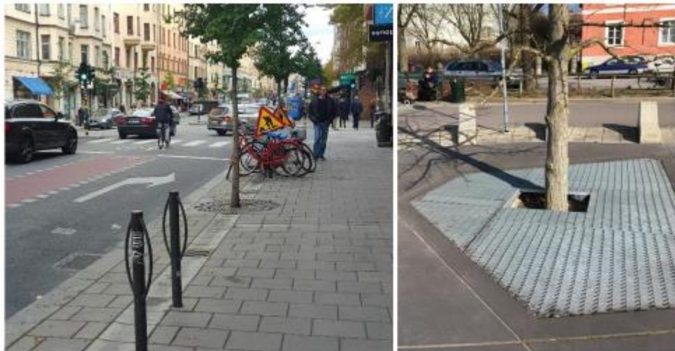
Figur 20 T.V. Exempelbild på trädgrop där vattnet avvattnas via rännor för trottoar till trädgrop och dagvattenbrunn från gata (Ramboll). T.H. Nedsänkt trädgrop med markgaller (Ramboll).
