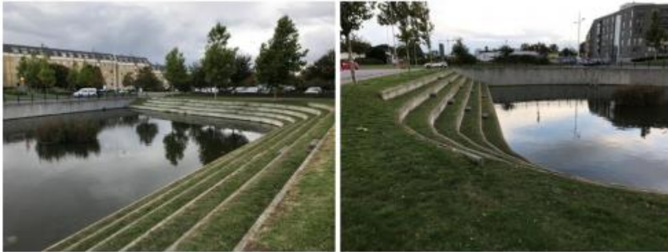
Figur 24 Exempelbild på öppet torr damm efter en regnhändelse med kajkant och trappsteg (Ramboll).
