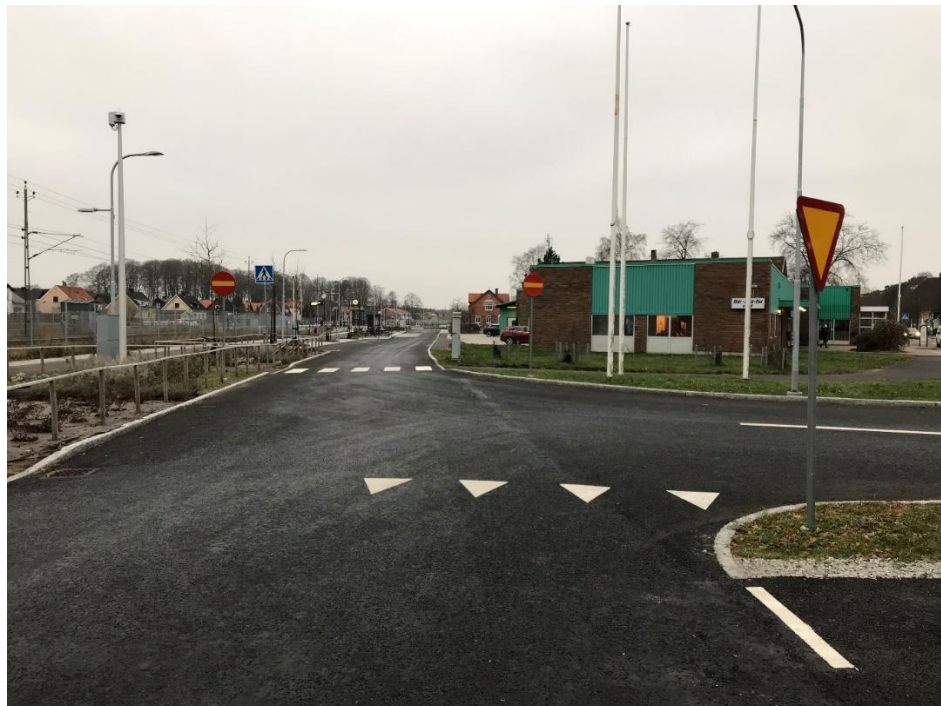
Figur 7. Järnvägsgatan sett från öster.
